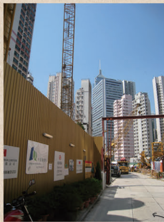
攝於2009年：重建進行中
