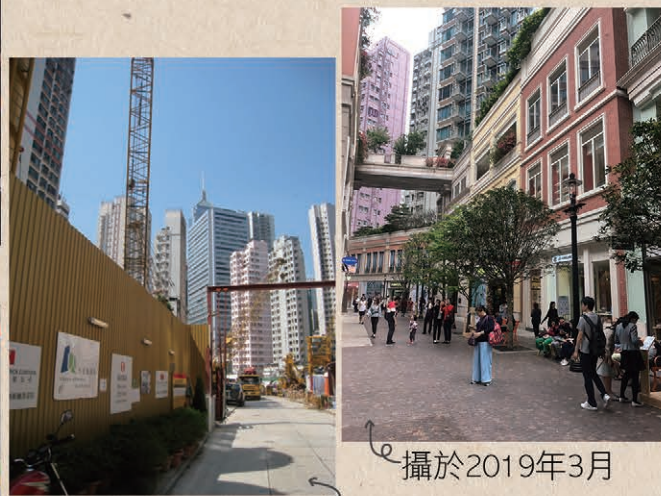
攝於2009年：重建進行中
